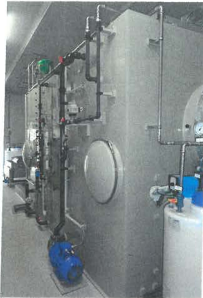
Ein Wäscher scheidet Partikel und Stäube ab, um ein Verstopfen der Anlage zu verhindern.
