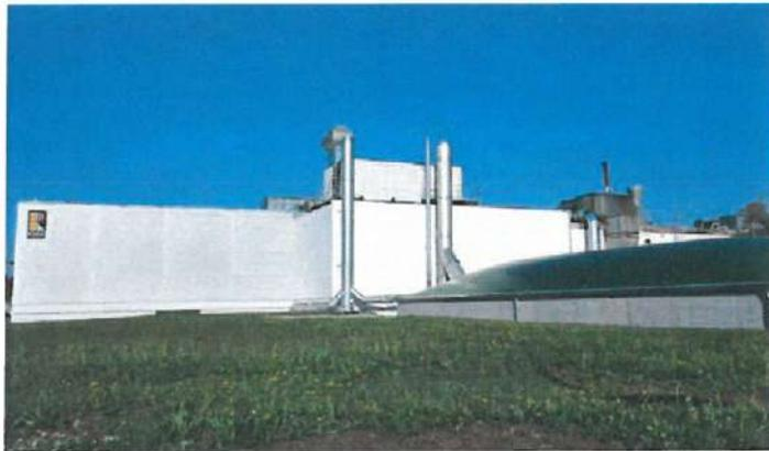
Mit der Abluftreinigungsanlage (rechts) erfüllt Reichert Holztechnik die Vorgaben der VOC-Richtlinie. Die auf einem Trägermaterial lebenden Bakterien ernähren sich von den Kohlenwasserstoffen. Quelle: Reichert Holztechnik
